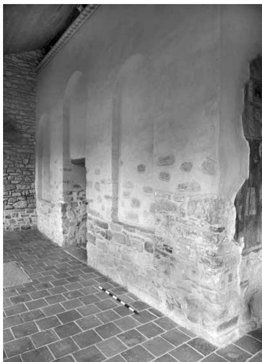
Обр. 30. Източната дълга стена на галерията (западна фасада на притвора) на църквата „Св. Апостоли Петър и Павел“ във Велико Търново – поглед от юг.
