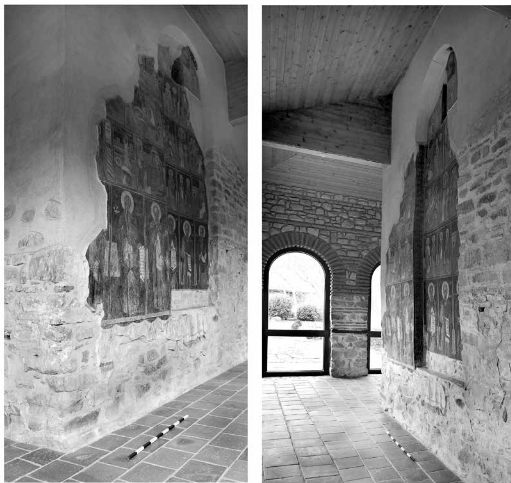
Обр. 31. Западна ниша на северната дълга стена на галерията (южна фасада на притвора) на църквата „Св. Апостоли Петър и Павел“ във Велико Търново – поглед от запад и от изток.
